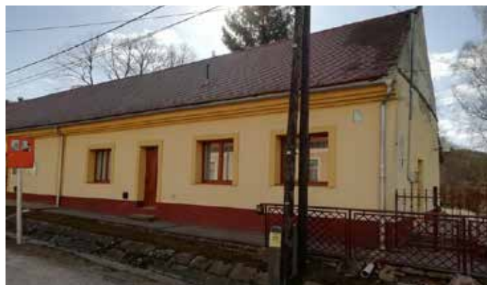
A cikói könyvtár épületénél hamarosan szigetelési munka kezdődik
